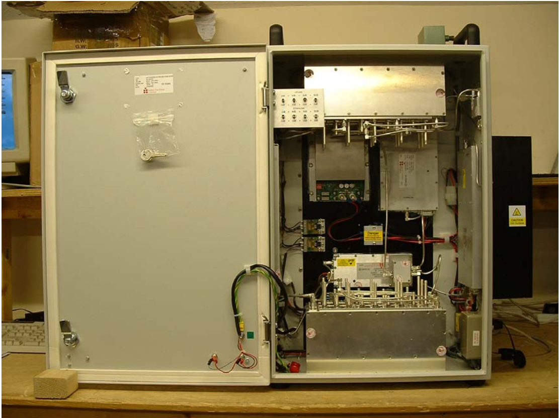
Door Open Overview
