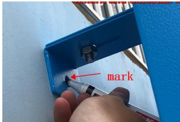
将固定块 1 拆下，使用活动扳手将取下的垫片及螺母安装到墙面上，如下图所示：
