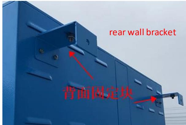
使用记号笔标记背面固定块的靠墙安装孔位，如下图所示。挪开柜子后，使用电钻对标记位置进行打孔，使用锤子将膨胀螺丝打入孔中，并取出膨胀螺丝上的垫片及螺母。将整柜挪至安装位置，膨胀螺丝穿过安装孔，使用活动扳手将取下的垫片及螺母安装上去。
