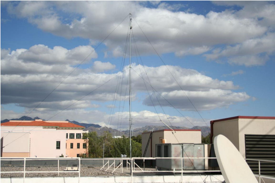
Las Cruces, NM: Inverted V antenna
